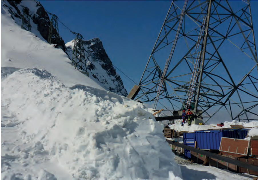
Abbildung 103: Stütze 1 der Säntisbahn während der Reparaturarbeiten im Frühling. An der linken Ecke der Stütze sind der Ablenkkeil und die verbogenen Streben sichtbar (Foto: P. Diener, 17.04.2019).
