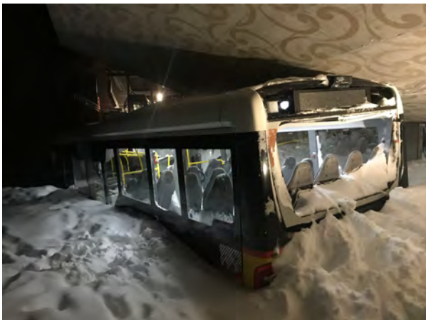
Abbildung 97: Das Postauto wurde von der Lawine erfasst und gegen den Eingangsbereich des Hotels Sântis gedrückt. Der Fahrer befand sich zum Zeitpunkt der Lawine ausserhalb des Postautos und wurde ganz verschüttet. Ein Mitarbeiter der Sântisbahn entdeckte ihn dank eines hervorschauenden Fusses (Foto: H. Schoop, 10.01.2019).
