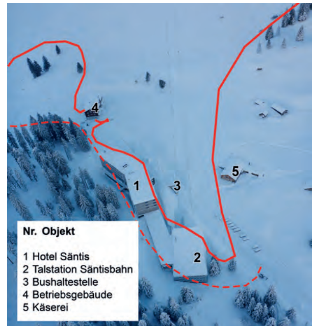
Abbildung 93: Hauptarm des Auslaufbereiches der Lawine, die das Hotel Säntis und die umliegenden Gebäude traf. Rot: Front der Ablagerung, rot gestrichelt: ungefähre Front der Staublawine und Druckeinwirkung (Foto: P. Diener, 11.01.2019)
