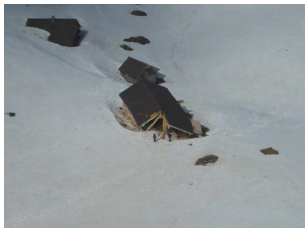
Abbildung 100: Algebäude Zweigemmer mit den Zerstörungsspuren der Lawine (Foto: P. Diener, 17.04.2019)
